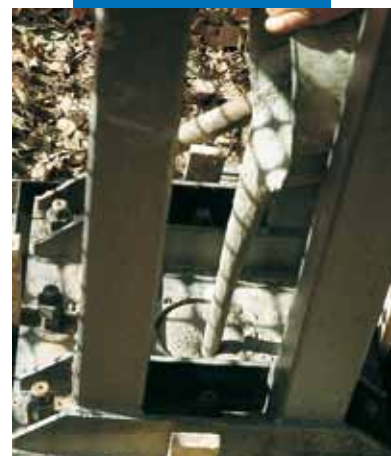
Kotwienie z użyciem Mapefill
