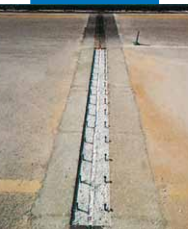
Naprawa sztywnych złączy mostu na autostradzie z użyciem Mapecifill
